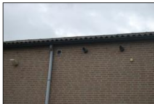
Links: Noordelijkste bedrijfsgebouw langs de Beusichemseweg. Rechts: Detail bedrijfsgebouw met beluchtingsspleten.
